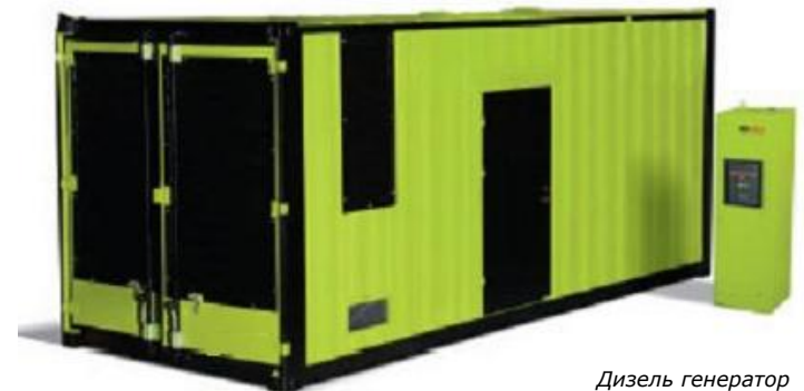
Дизель генератор в блок контейнере.
