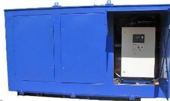
дизельная электростанция в энергомодуле.
